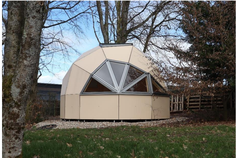
Ein Geodome von Vision Domes als erster Prototyp für die nachhaltige Dämmplatte aus Teereststoffen. © Vision Domes
